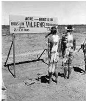
Obras da rodovia Acre-Brasília, julho/1960
